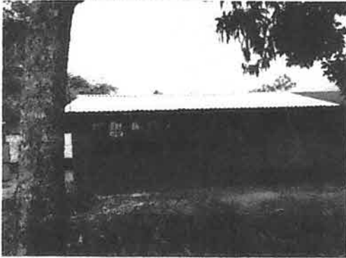
Foto 1: sustitucion de lámina.
