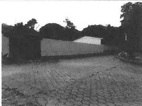
Foto 5: Sustitucion de pintura.
